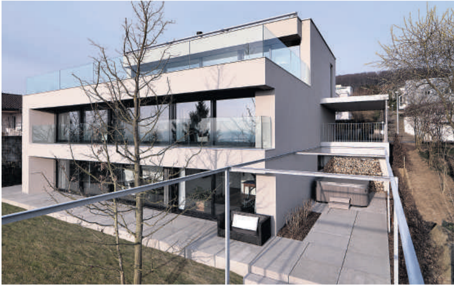
Aufstockung: Attikawohnung auf dem Flachdach. Die Wohnung im Gartengeschoss ist 80 m 2 gross
