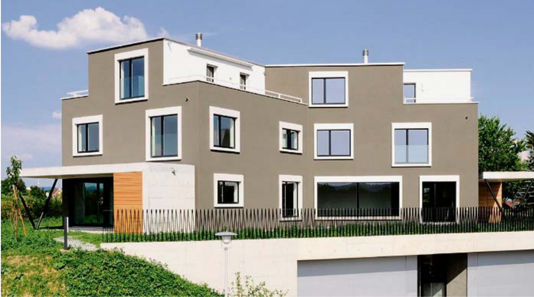
Raffinierter Hell-dunkel-Wechsel: Dank ausgeklügelter Farbgebung fügt sich das Gebäude diskret in die Umgebung ein
