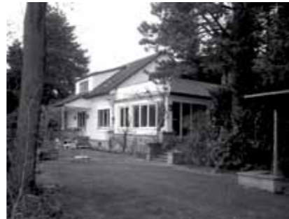
Vor dem Umbau
